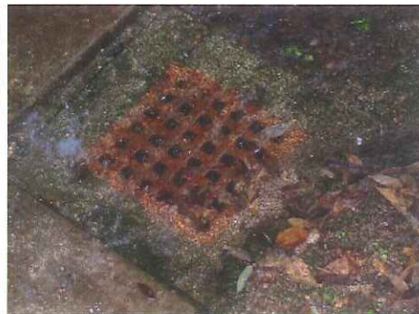
図3 中庭の排水口
