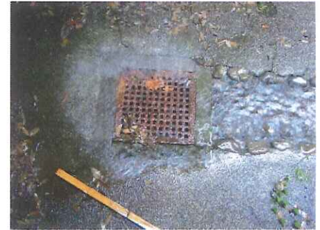
図5 玄関脇の排水口
